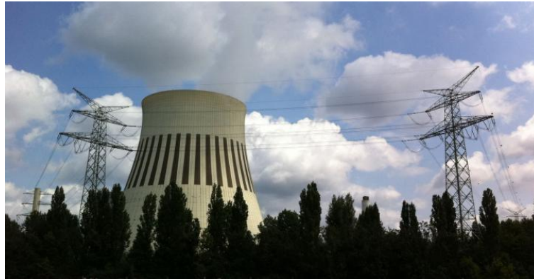
Die Fernwärmeversorgung in Berlin soll kohlefrei werden. (Foto: Christian Seelos)
